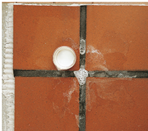
Elimination des efflorescences
