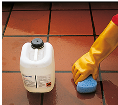
Nettoyage avec Keranet liquide
