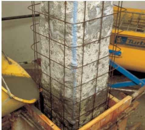
Coulage dans un coffrage
